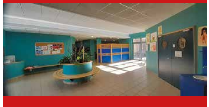
Réfection des peintures du hall d'entrée de l'école
