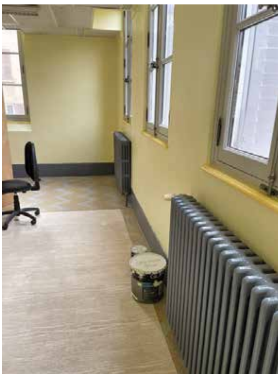
Réfection d'une des salles de la bibliothèque
